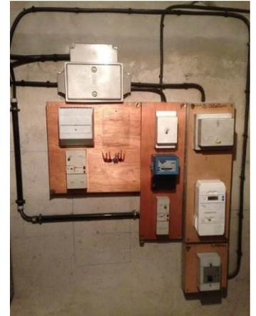
Certains disjoncteurs de branchement sont obsolètes (pas de bouton test, ni de dispositif différentiel imposé par la norme NFC-14-100) et vétustes. Ceux-ci devront être remplacés par des modèles différentiels sélectifs.
