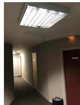
Il n'existe qu'une seule minuterie par étage, pour les trois circulations, le luminaire du palier étant permanent.
