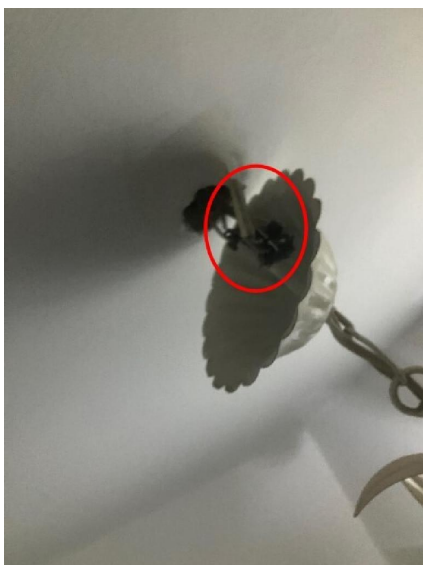
B.7.3 d) : L'installation électrique comporte au moins une connexion avec une partie active nue sous tension accessible. Observation : Dominos : connections des luminaires
