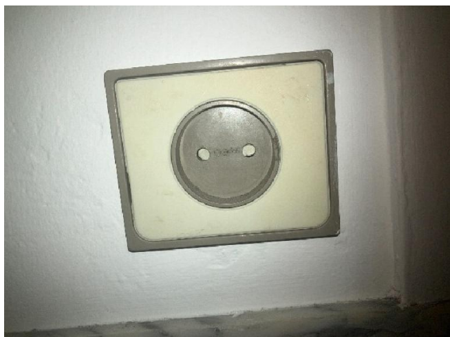
B.3.3.6 a1) : Au moins un socle de prise de courant ne comporte pas de broche de terre. Observation : Prise sans connecteur de terre
